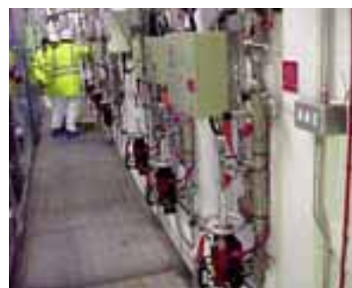
Vannes de sectionnement
