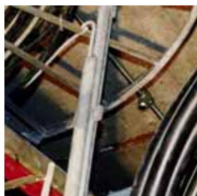
Installation facile des buses dans le plafond
