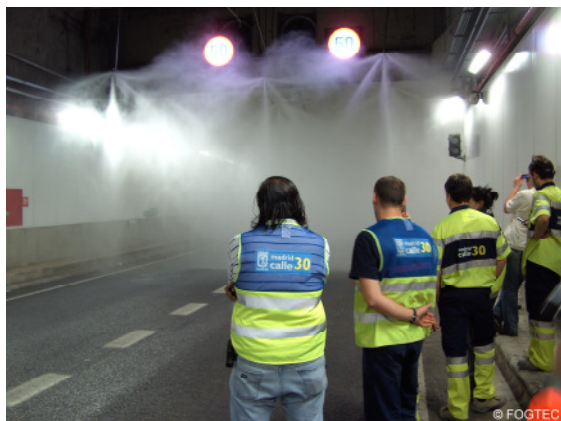
Sprühversuch in Tunneln der M 30
